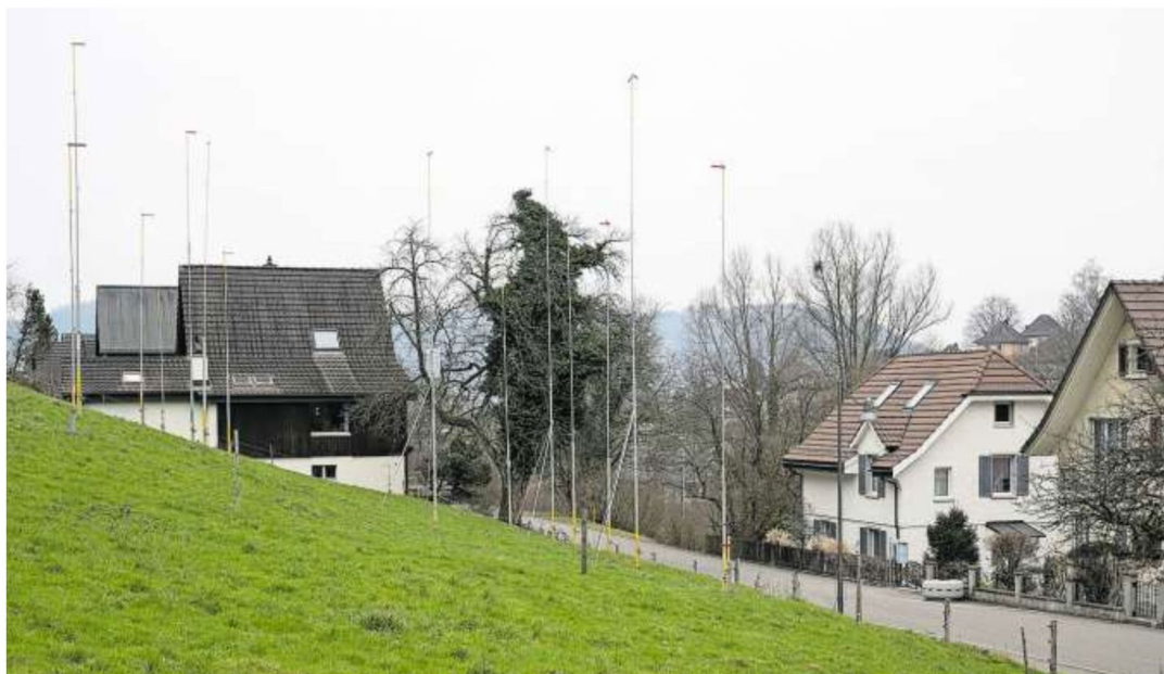
Die Bauprofile lassen das Volumen des Neubaus erahnen.
