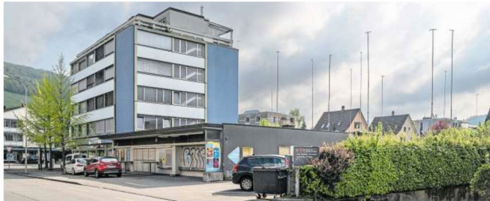
Seit April 2020 ragen die Bauprofile in die Höhe. Vorne die Post Langenstein, die inzwischen geschlossen ist. Sie wird abgerissen. Bild: Andrea Zahler (April 2023)
