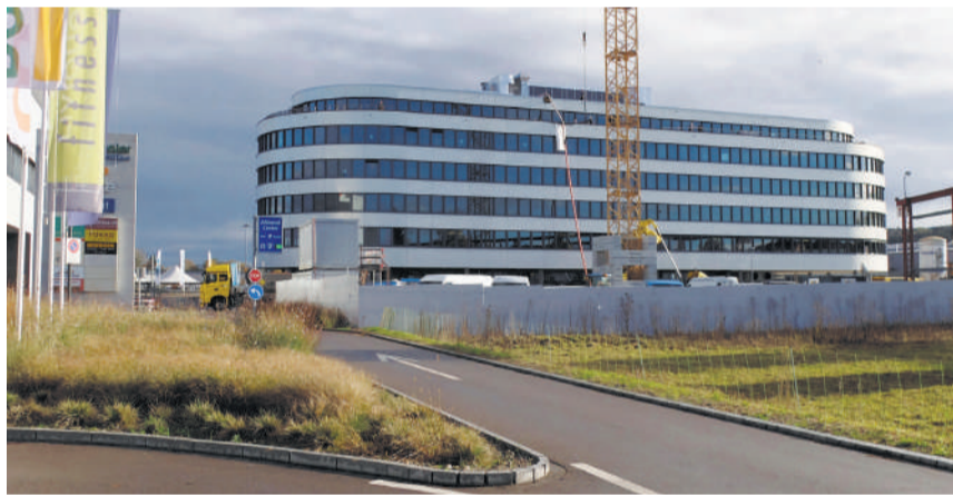
Die Fassade ist zurückhaltend und doch elegant gestaltet.
