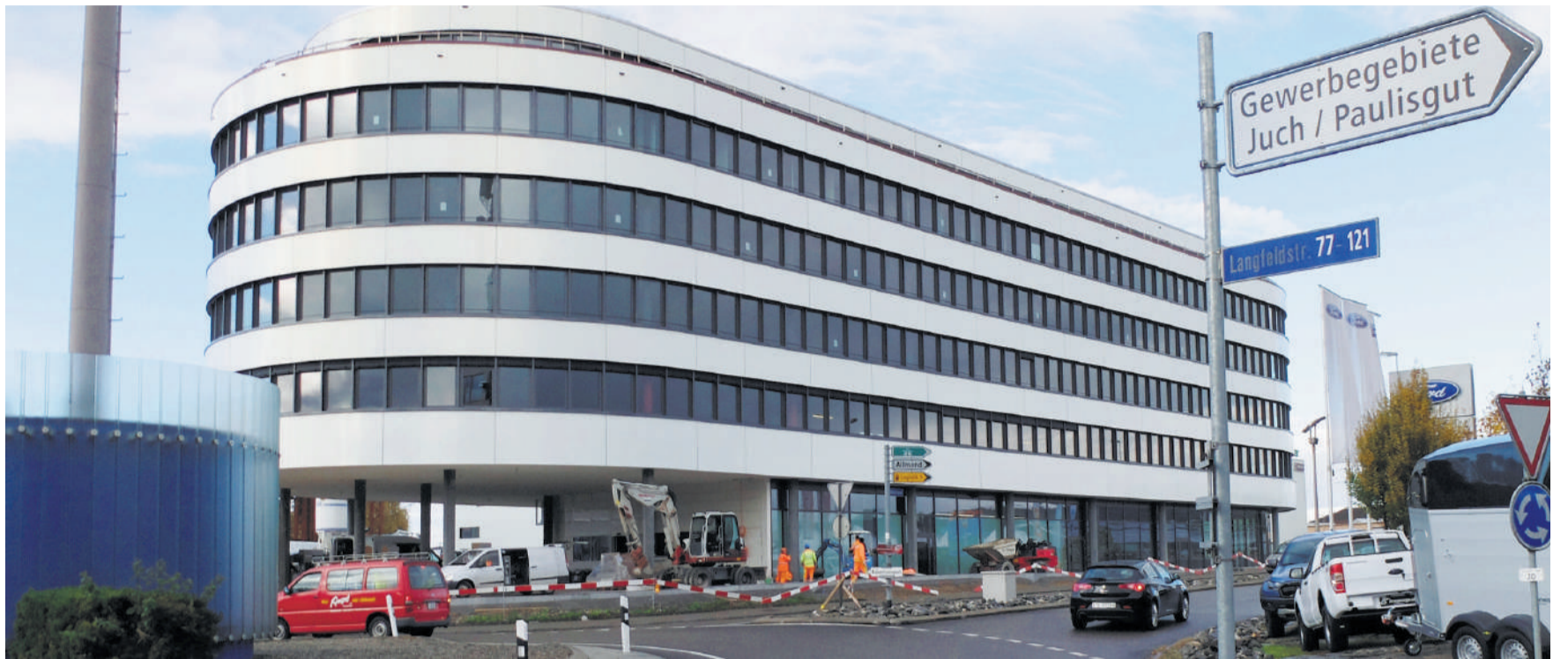
Als erste Bauetappe wurde das Gebäude direkt am Kreisel Oststrasse/Langfeldstrasse realisiert.
