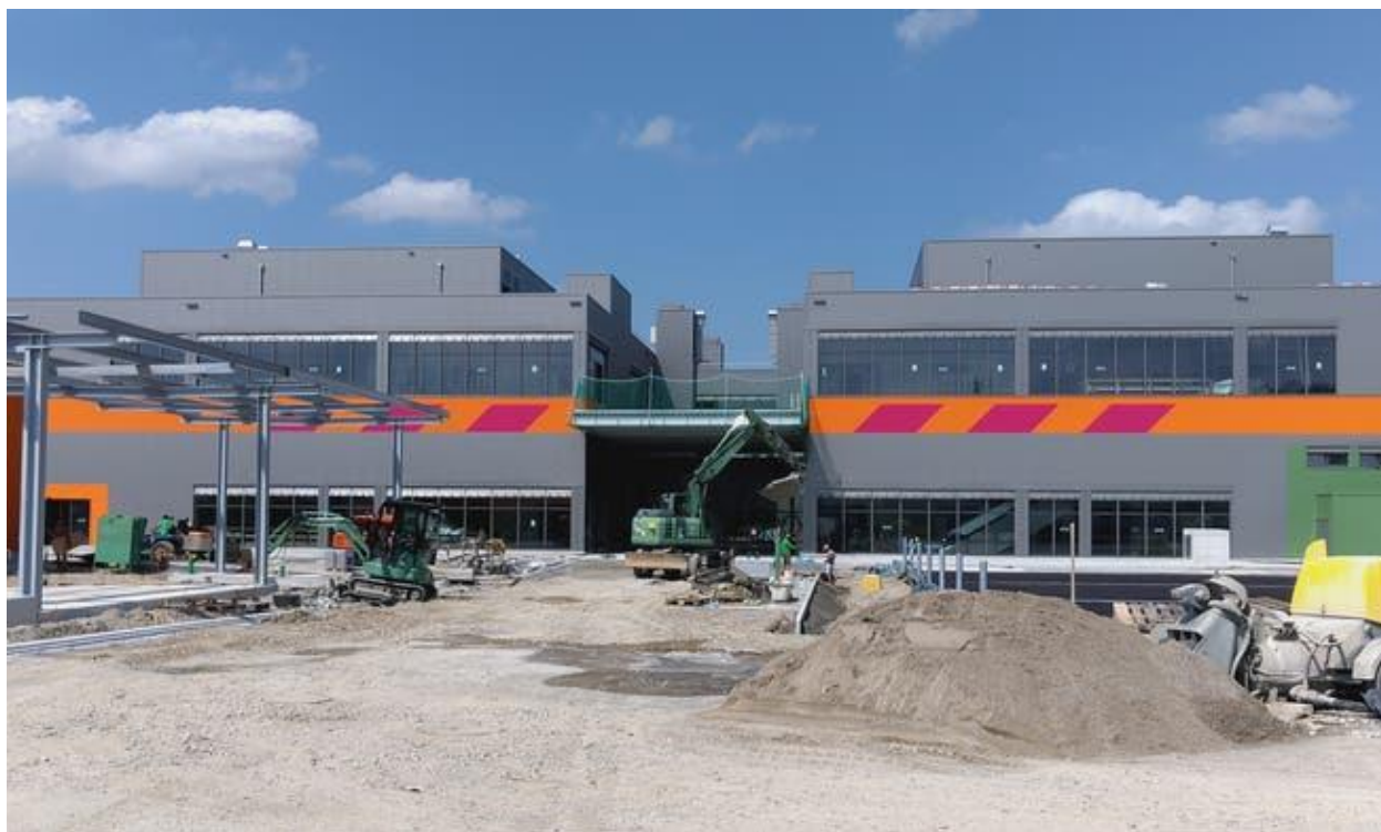
Baustelle des Ebnet Centers in Sirmach. Bild: Thomas Griesser Kym (20. Juli 2021)
