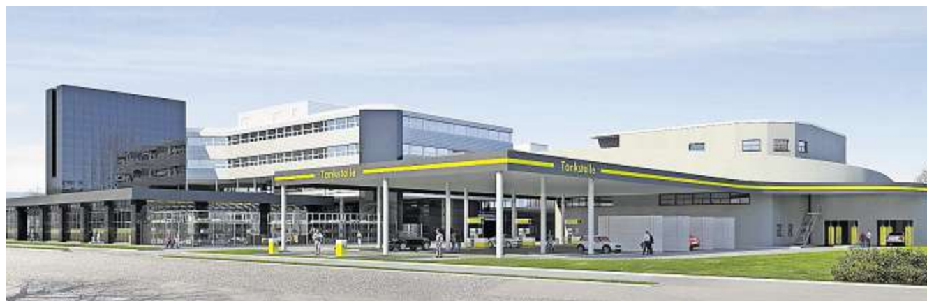
Die Tankanlage im Riedmatt Center bekommt moderne Tankplätze, ein Dach und einen Shop. Visualisierung: pd
