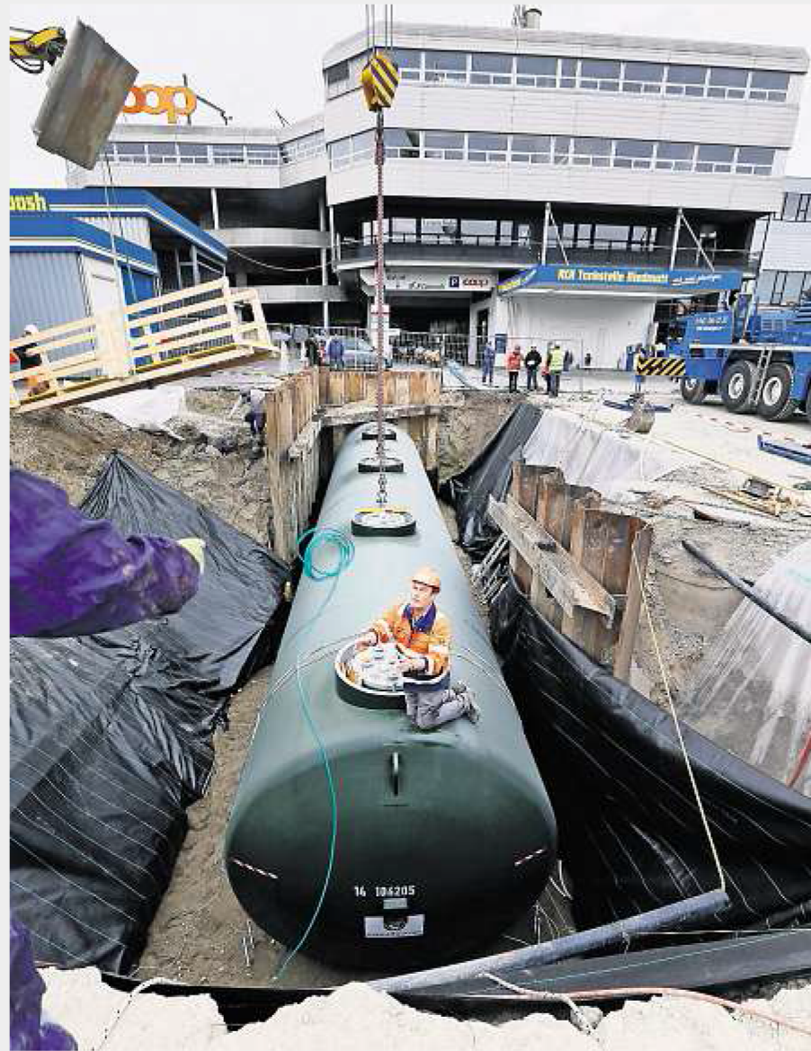
Servicemonteur Ade Wildburger bindet schon mal die Kabel um. Später wird der Tank mit Metallriemen fixiert. Hinter ihm die vier Anschlüsse für Benzin und Diesel.
